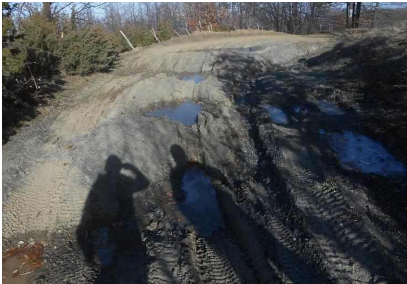
Come si presenta un tratto della Flaminia Minor Via Casoni di Romagna - N44° 13' 29.7" E11° 23' 54.8" il 18/01/2018 ma anche a maggio 2019
